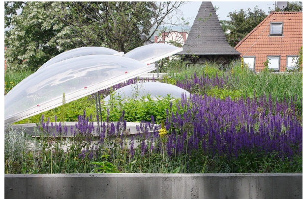
Ein intensiv begrüntes Dach.
